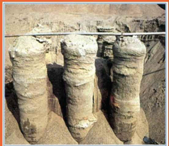
Cột JSP Sau Khi Thi Công
